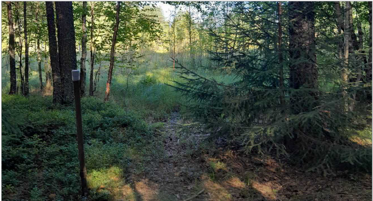
Kuva 12. Hulevesien imeytysalue Soppeenmäen teollisuusalueella. Etualalla imeytyspaikan yhteydessä oleva havaintoputki.
