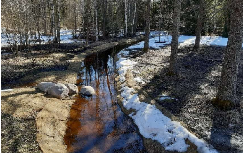
Kuva 12. Hulevesien purku-uomien reunat tulisi eroosiosuojata tarvittaessa. Suojaukseen voidaan käyttää esimerkiksi maatuvaa eroosiosuojamattoa. © Destia 2024.
