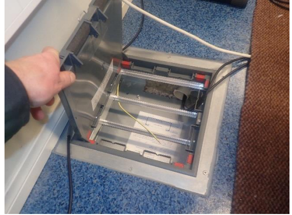
Kuva 57 Musiikkiluokan 104 levyrakenteiseen lattiaan upotettuja valurasioita.
