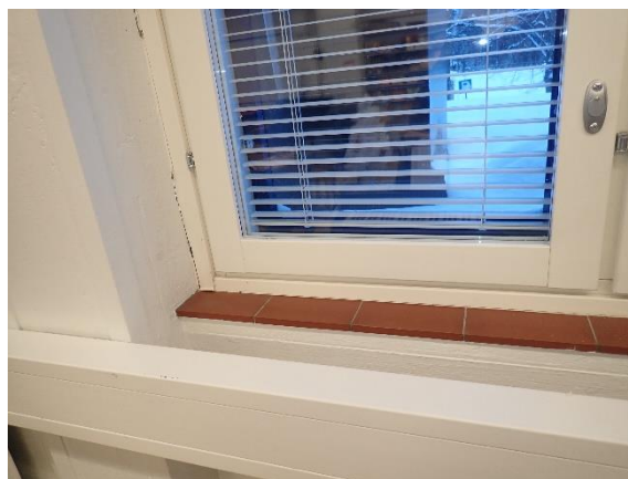
Kuva 42 Alkuperäinen rakennusosa, ikkunat uu- sittu.
