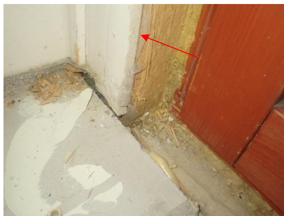
Kuva 40 Laajennusosalla ikkunaliittymässä on uretaanivaahdotus. Levyrakenteisen seinän sisäpuolella kipsilevyn takana höyrynsulkumuovi.
