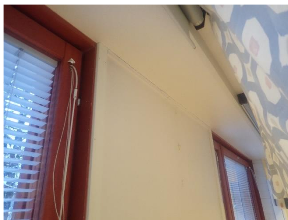
Kuva 38 Yleiskuva, laajennusosalla ikkunoiden välisillä osuuksilla levyrakenne.
