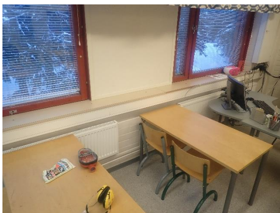
Kuva 37 Yleiskuva, laajennusosan ulkoseinä- rakenne ja ikkunat. Ikkunoiden välisillä osuuksilla levyrakenne.
