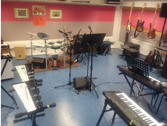
Kuva 56 Musiikkiluokan 104 takaosan lattia on levyrakenteinen.
