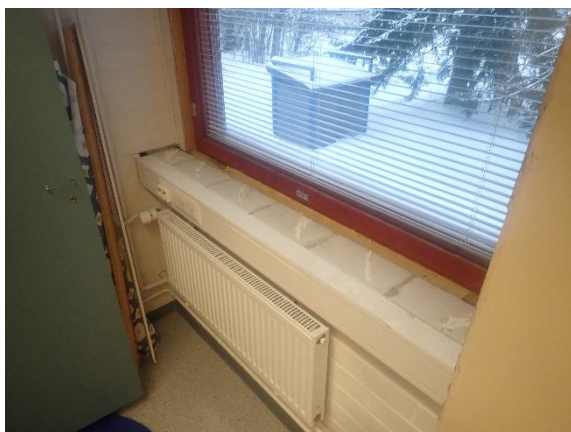
Kuva 39 Yleiskuva, avattu ikkunapenkkirakenne laajennusosalla.
