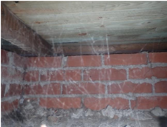
Kuva 76 Yläpohjan räystäällä on runsas tuuletusväli.
