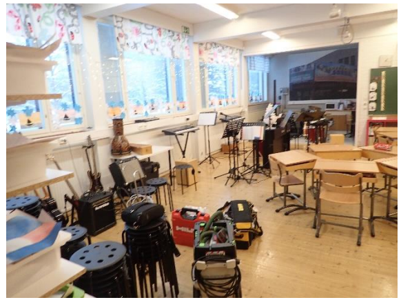
Kuva 59 Opetustilassa 154 oli poikkeavasti lautarakenteinen lattia.
