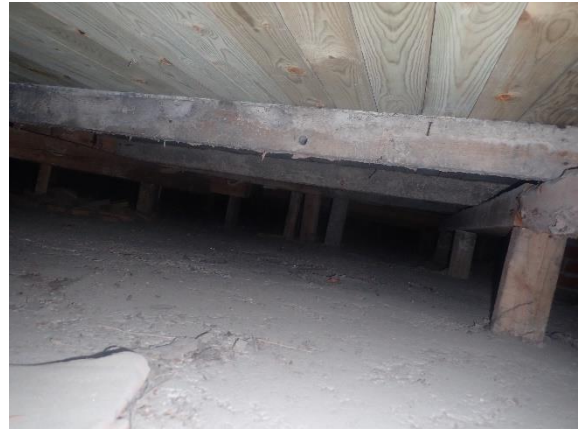
Kuva 75 Yläpohjan eristeiden päällä on ohut betonilaatta.
