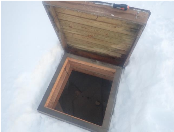
Kuva 74 Yleiskuva, vesikatolta on tarkastusluukku yläpohjaan.
