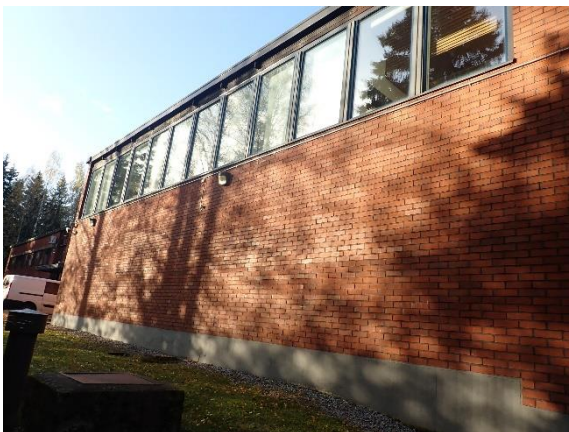
Kuva 7 Julkisivut ovat tiilimuurattuja.
