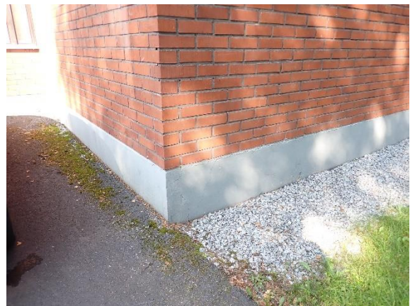
Kuva 8 Kuva sokkelirakenteesta liikuntasalin kulmassa.
