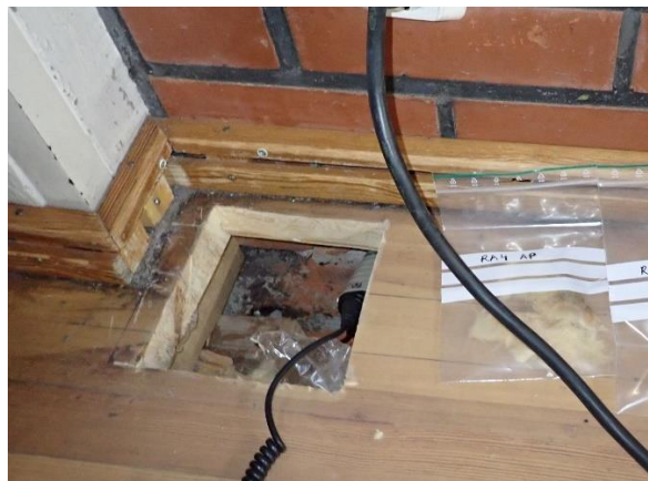
Kuva 12 MP4 mittaus tehtiin lattian alapuolelle ulkoseinän villan alaosaan.
