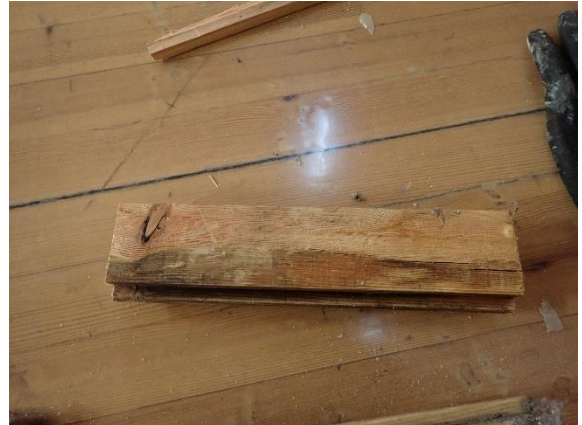
Kuva 10 Vuoto on kastellut lattialautaa, jossa ruskea jälki. Puu oli alapinnastaan kosketusmärkä.
