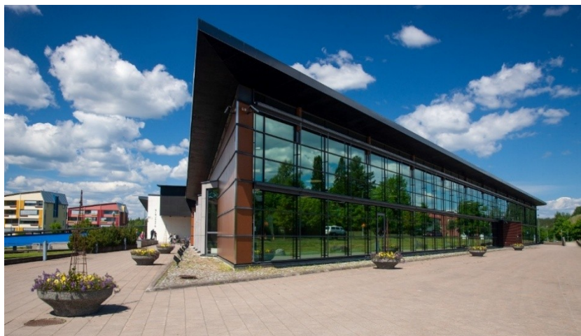
Kuva 6, Leijakirjasto valmistui vuonna 2002 (Kuva: Ylöjärven kaupungin kuvapankki). Taistalla näkyvät Kultaniityn asuinrakennukset (kilpailuvoitto / Kirsti Sivén ja Asko Takala)
