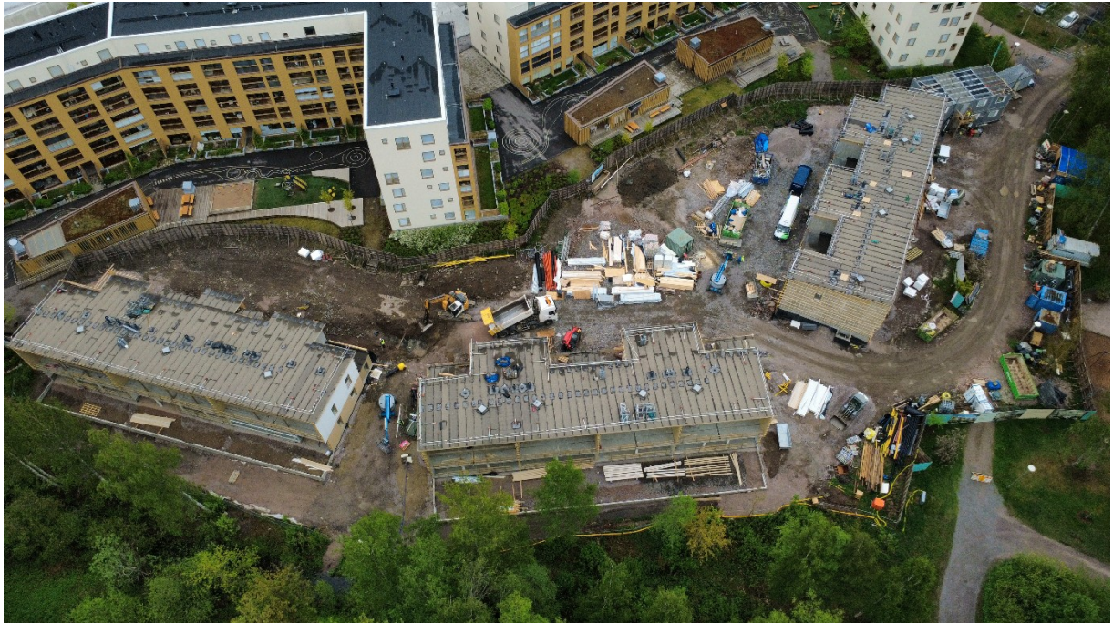
Kuva 41, Havainnekuva työmaa-aikaiselta pihojen suojauksesta, kuva Tuulikello 3/Bonava, Saku Laine
