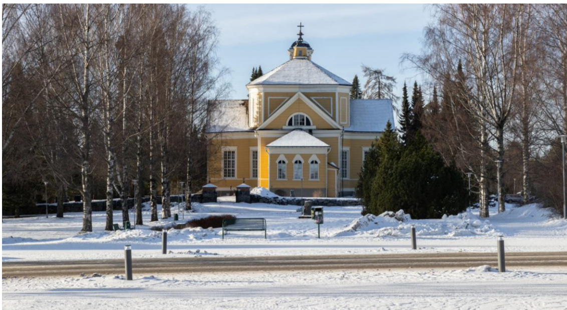
Kuva 19, Ylöjärven länsitornillinen ristikirkko kirkko v. 1850 sijaitsee vastapäätä kaupungintaloa (kuva: Rami Marjamäki). Kaupungintalo on valmistunut vuonna 2011 (Helamaa-Heiskanen).
