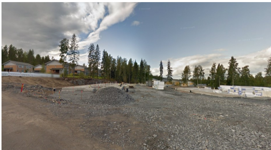
Google street view kuva syyskuulta 2011, Lohkaretien korttelin 234 rakennustöistä. Puut ovat kaatuneet ja lähinnä harjua näkyy toteutuneet korttelin 233 paritalot.
