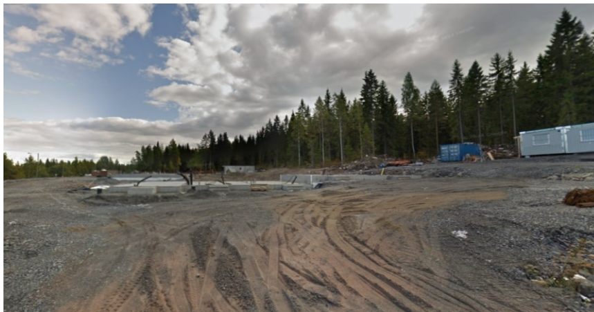
Google street view kuva syyskuulta 2011, Lohkaretien korttelin 235 rakennustöistä. Puut ovat kaatuneet.
