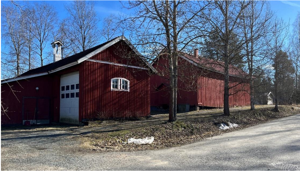
Kuva 12. Reetankujan varren talousrakennuksia, vasemmalla autotalli/hevostalli (nro 3) oikealla lato (nro 2). Kuva: Sweco.
