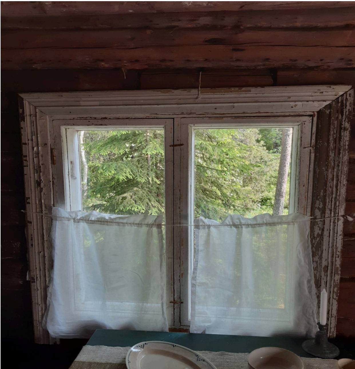
Ikkunoiden laudat hilseilevät ja mennyt huonoon kuntoon. Pitäisi maalata.
