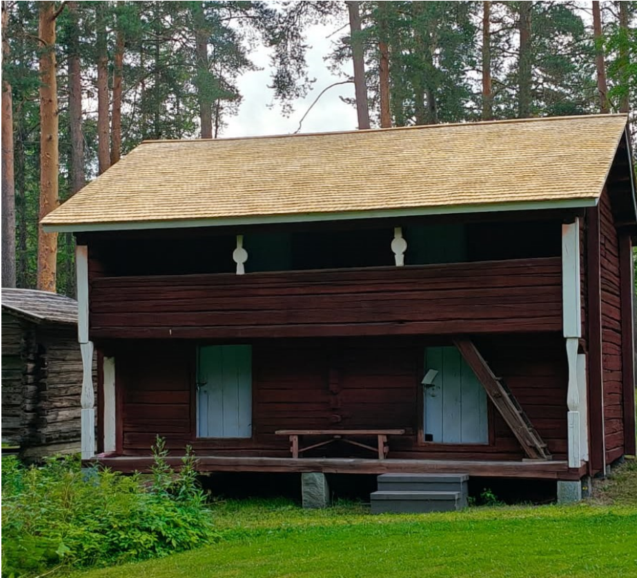
Kuva 20 Luhtiaitta sai uuden pärekaton. Työn toteutti Rakres.
