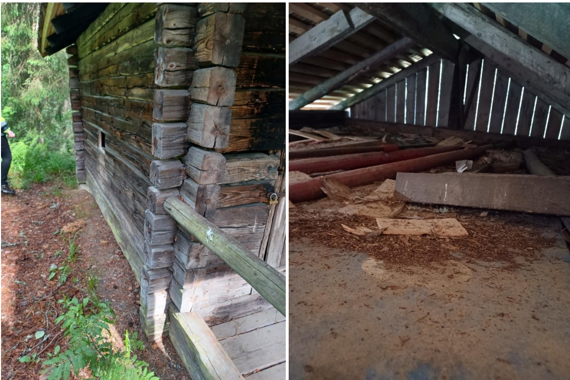
Kuvat 14 ja 15 Perinnerakennusmestari Ritva Ruponen suositteli, että maa-ainesta otetaan pois savusaunojen hirsien vierestä niin, että kivijalka erottuisi paremmin ja välikatossa olevat puuainekset korjattaisiin pois palokuorman vähentämiseksi.
