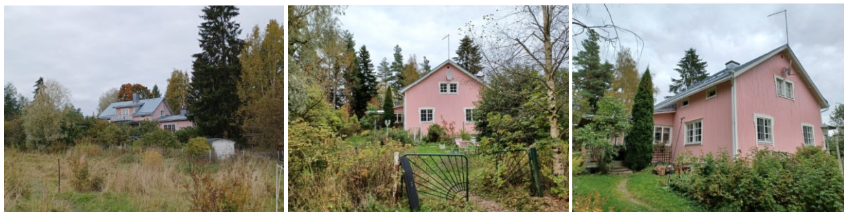
Kuvat: Vasemmalla rakennus laajennuksineen tieltä katsottuna. (Ks. myös s. 6.) Keskellä asuinrakennus lounaasta. Oikealla asuinrakennus luoteesta, sisäänkäynnin puolelta.
