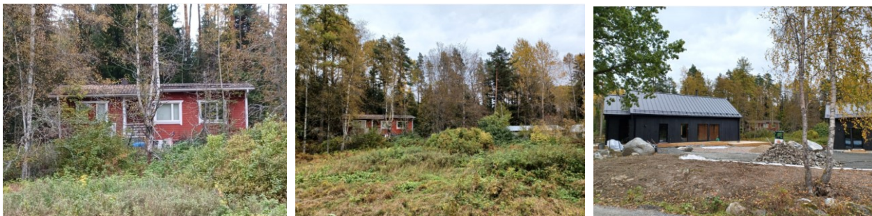
Kuvat: Vasemmalla Laakson asuinrakennus lounaasta. Keskellä asuinrakennus ja sen oikealla puolella pilkottavat vaaleat talousrakennukset. Oikealla vanhalle rakennuspaikalle rakennetut uudisrakennukset ja niiden välistä näkyvä Laakson asuinrakennus.
