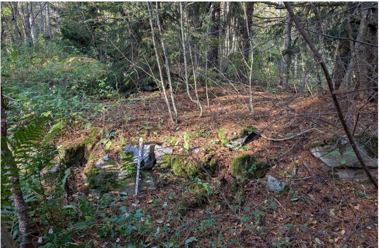
Kuva 9. Rakennuksen eteläisintä kivijalan osaa. Pohjoiseen.
