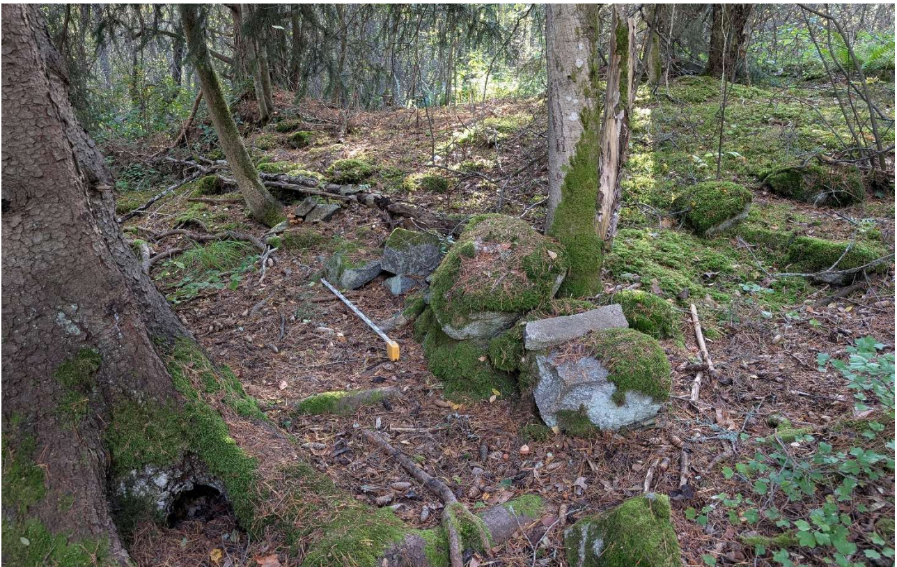
Kuva 7. Rakennuksen sammaloitunutta kivijalkaa. Lounaaseen.
