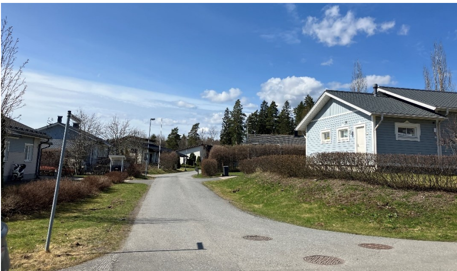
Kuva 15 Kaava-alueeseen rajautuvaa rakennuskantaa Asuntilan Pitkäsuontien varrelta.
