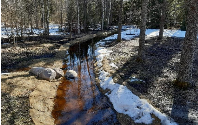
Kuva 15. Hulevesien purku-uomien reunat tulisi eroosiosuojata tarvittaessa. Suojaukseen voidaan käyttää esimerkiksi maatuvaa eroosiosuojamattoa. © Destia 2024.
