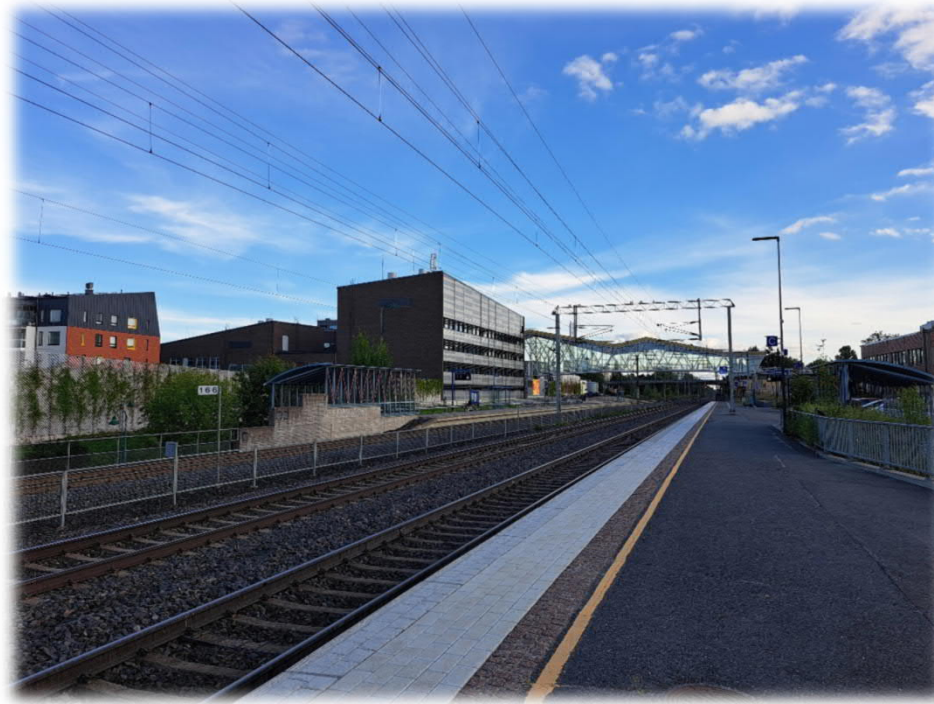
Kuva: Lempäälän asema. MAL4-sopimuksella rahoitettu reunalaiturien pidentämiset.
