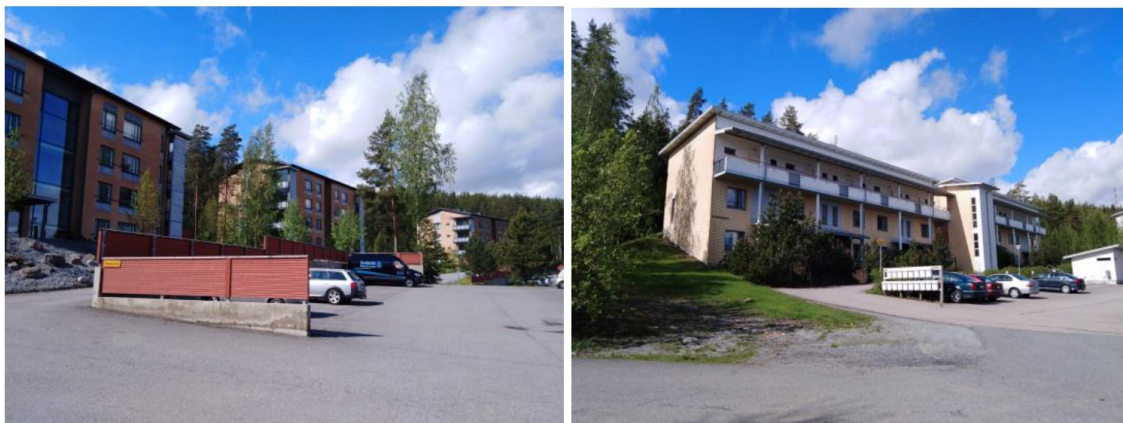
Asuinrakennuksia 2000-luvulta Mikkolantien varrelta, Sweco
