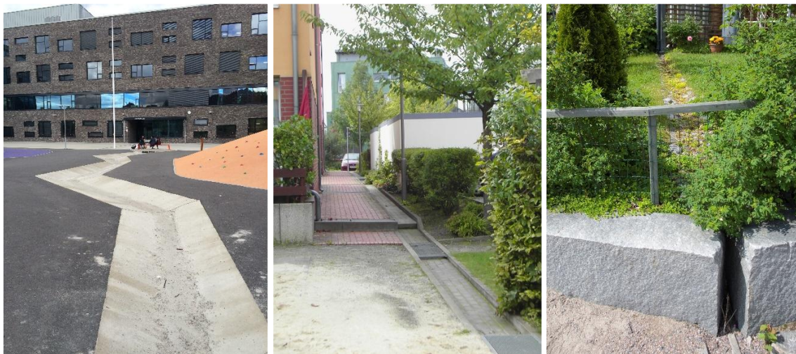
Kuvat 8-10. Hulevesien pintajohtaminen.
