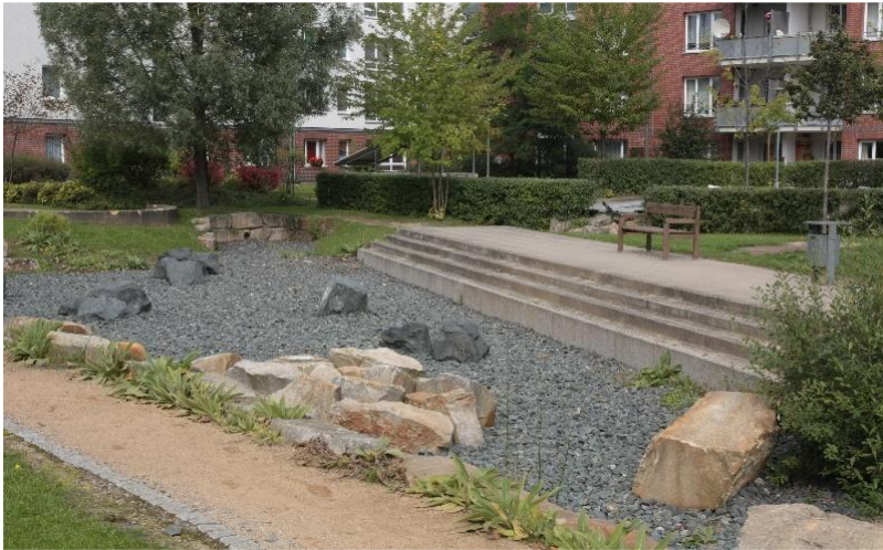
Kuva 11. Sateiden välillä tyhjentyvä viivytysallas kerrostalopihalla.
