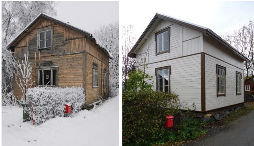
Kuva 7. Rakennuksen julkisivun korjaustyöt on toteutettu vanhoja yksityiskohtia palauttaen (kuva: Saatsi Arkkitehdit)
