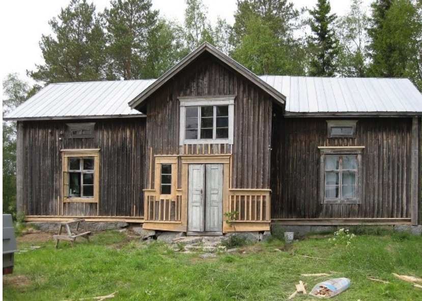
Kuva 8. Vain huonokuntoiset osat on korvattu uusilla puuosilla. (kuva: Saatsi Arkkitehdit.)
