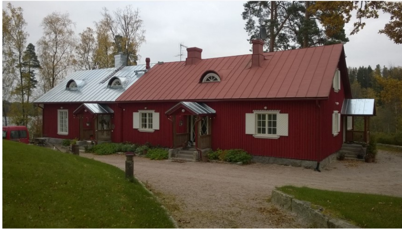
Kuva 10. vanhan rakennuksen laajennus toteutettu rungon levyisenä ja harjan suuntaisena . (kuva: Petri Karvinen)
