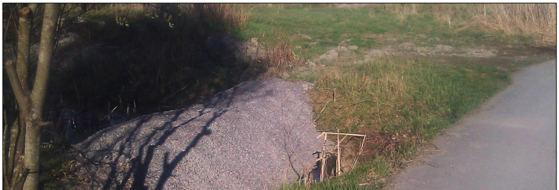
Kuva 7. Avo-ojan eteen rakennettu väliaikainen suodattava murskepato. Turku, Haارانlahti. 3
