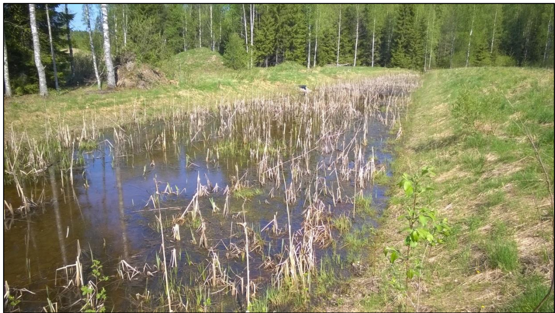
Kuva 3. Pohjoisempi rakennettu hulevesiallas 3
