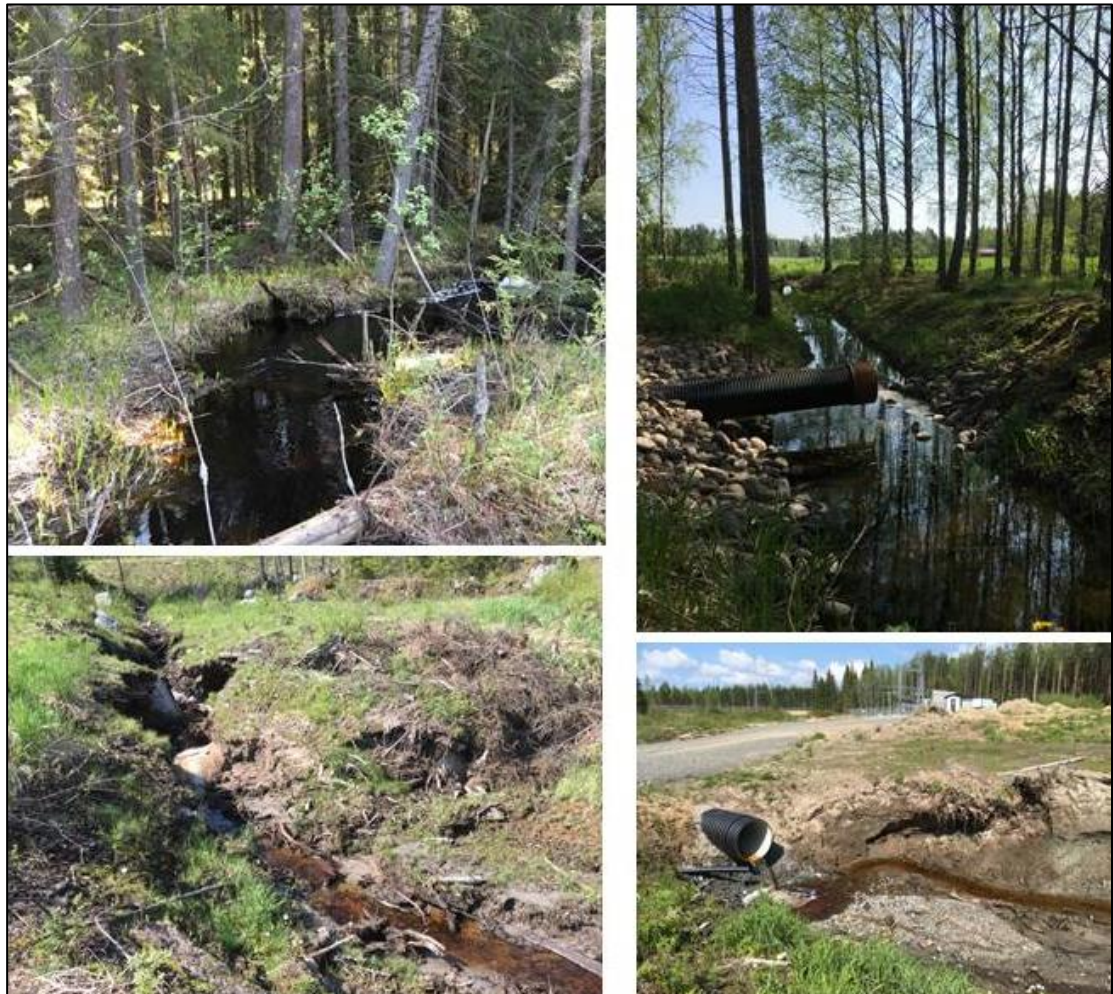
Kuva 2. Vas. yläkulma: Leppioja, oik. ylhäällä rakennetun hulevesialtaan purku Koreenniitynojaan, alhaalla esimerkkejä eroosiosta Malmimäen alueen halki kulkevassa ojassa. 3
