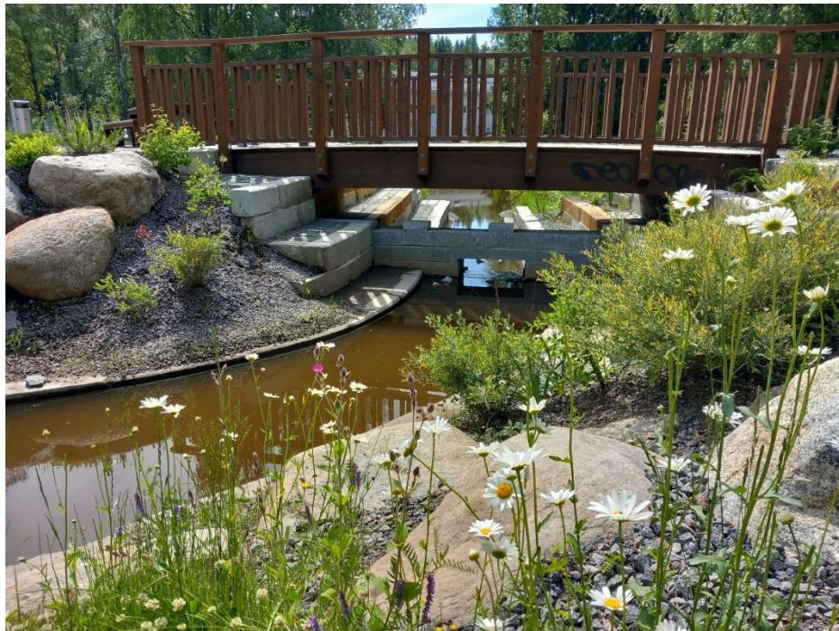
Kuva 15. Esimerkkikuva kapeasta hulevesikanavasta, jonka yli kulkee virkistysreitti. Kuva © Destia Oy.
