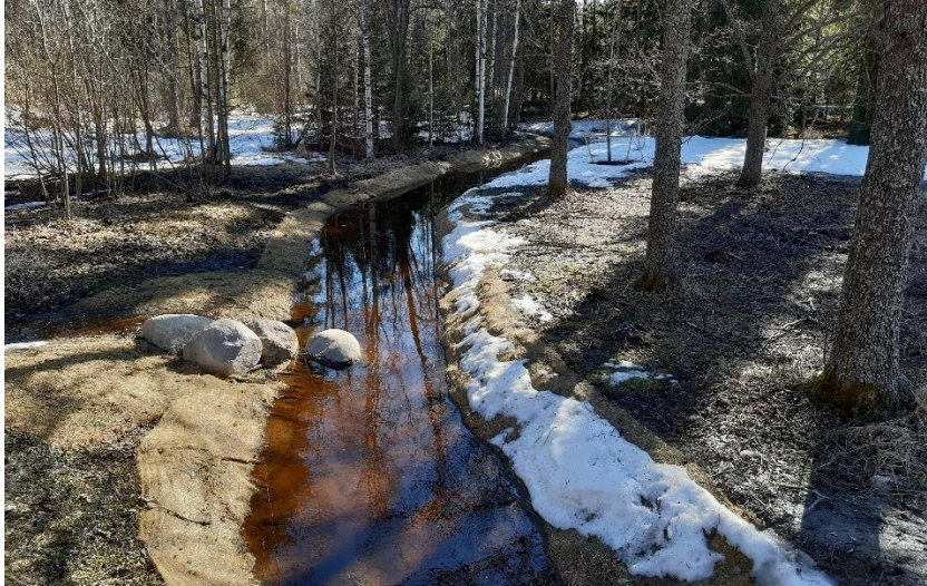
Kuva 16. Hulevesien purku-uomien reunat tulisi eroosiosuojata tarvittaessa. Suojaukseen voidaan käyttää esimerkiksi maatuvaa eroosiosuojamattoa. © Destia 2024.
