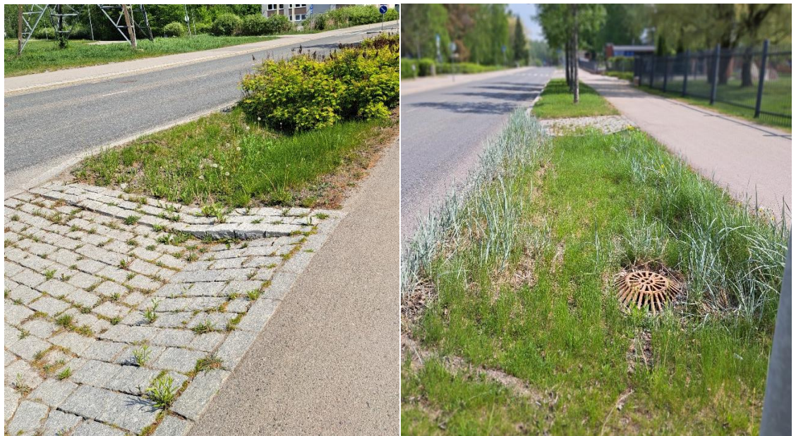
Kuva 13 A ja B. Esimerkki kadun viherkaistalle toteutetusta biosuodatusrakenteesta (Vantaan Meiramitie). Kuva © Destia Oy.
