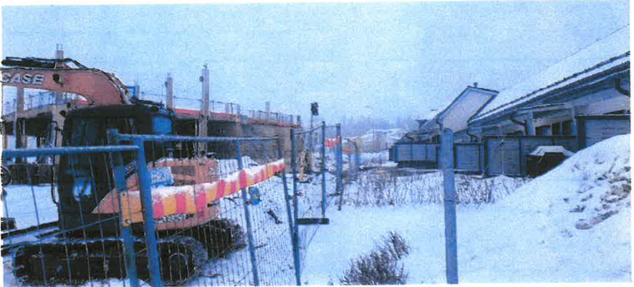
Siltatien päiväkodin työmaan ja asunto-osakeyhtiöiden välinen "aita" kuvattuna Lähdevainiontieltä päin 22.1.2025
