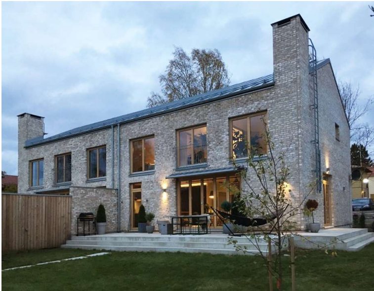
Esimerkki tiilisestä paritalosta, Kannunvalajantie, Helsinki
