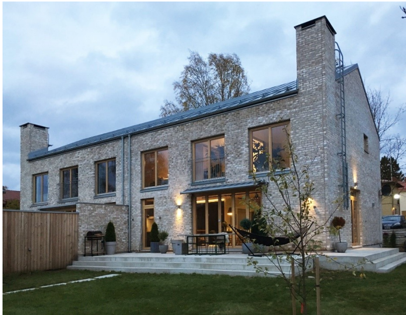
Esimerkki tiilisestä paritalosta, Kannunvalajantie, Helsinki
