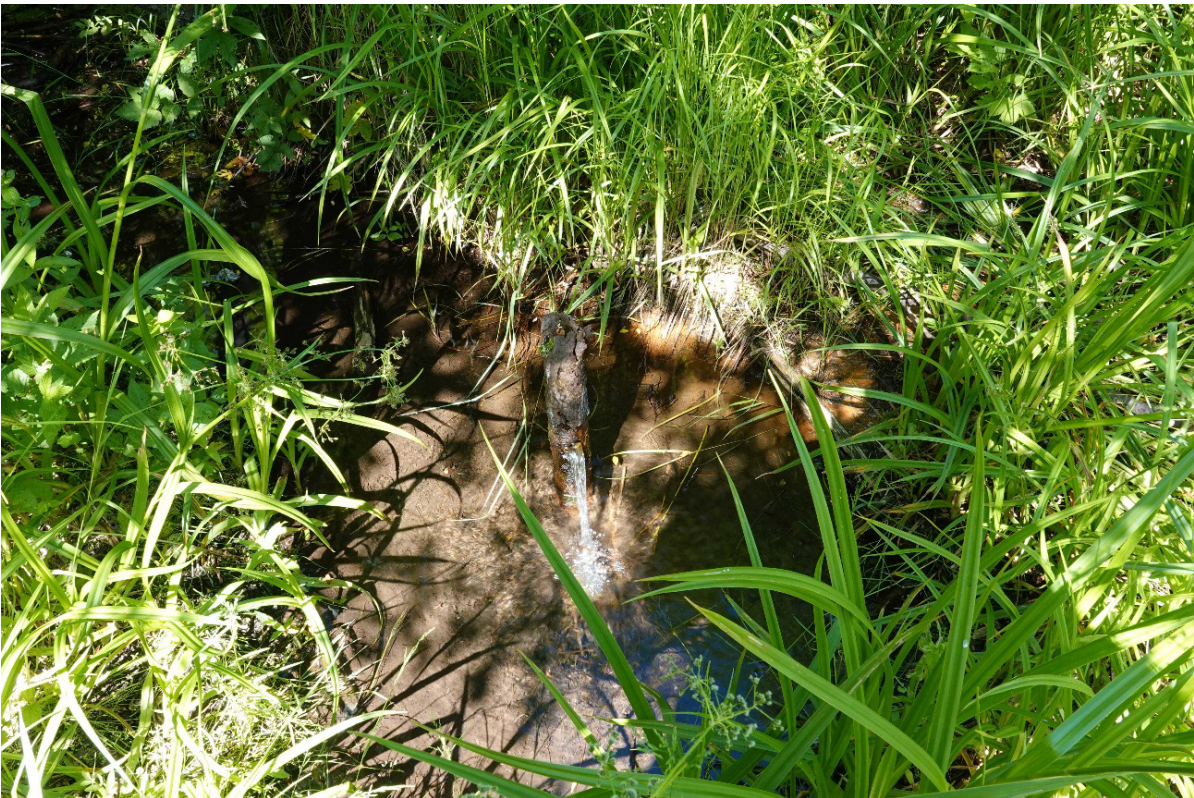
Kuva 7. Lähteeseen 3 on asennettu rautaputki.
