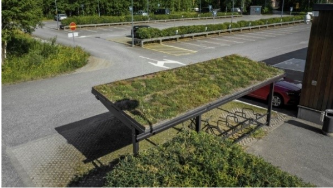
Kasvikatoksi toteutettu kevytrakenteinen pyöräkatos.
