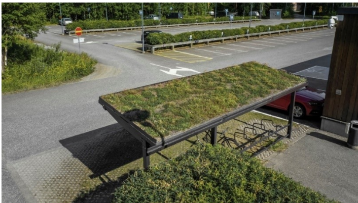
Kasvikatoksi toteutettu kevytrakenteinen pyöräkatos.
