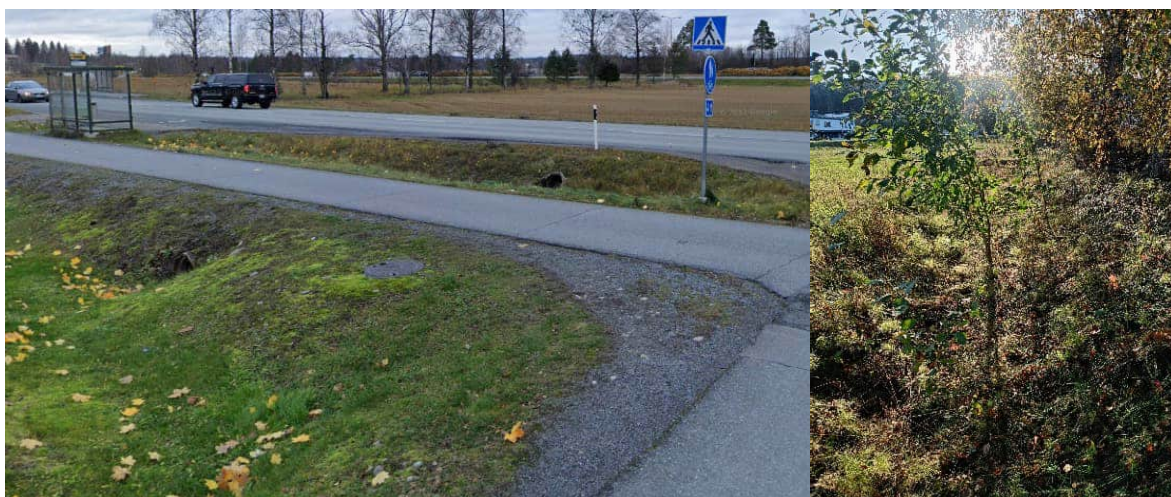
Kuva 8 Muinaisrannantien vieressä sijaitsevat rummut kevyen liikenneväylän alittava 600 b rumpu ja Mikkolantien alittava 800 b rumpu © Google Streetview. Vasemman kuvan yläreunassa ja oikeassa kuvassa peltotien "penger" ja puurivi.
