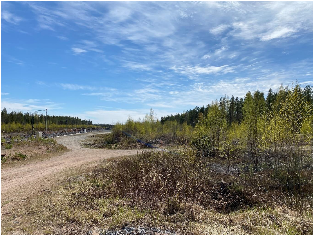
Kuva 4-15. Vahojärven liikennepaikan yleiskuva.
