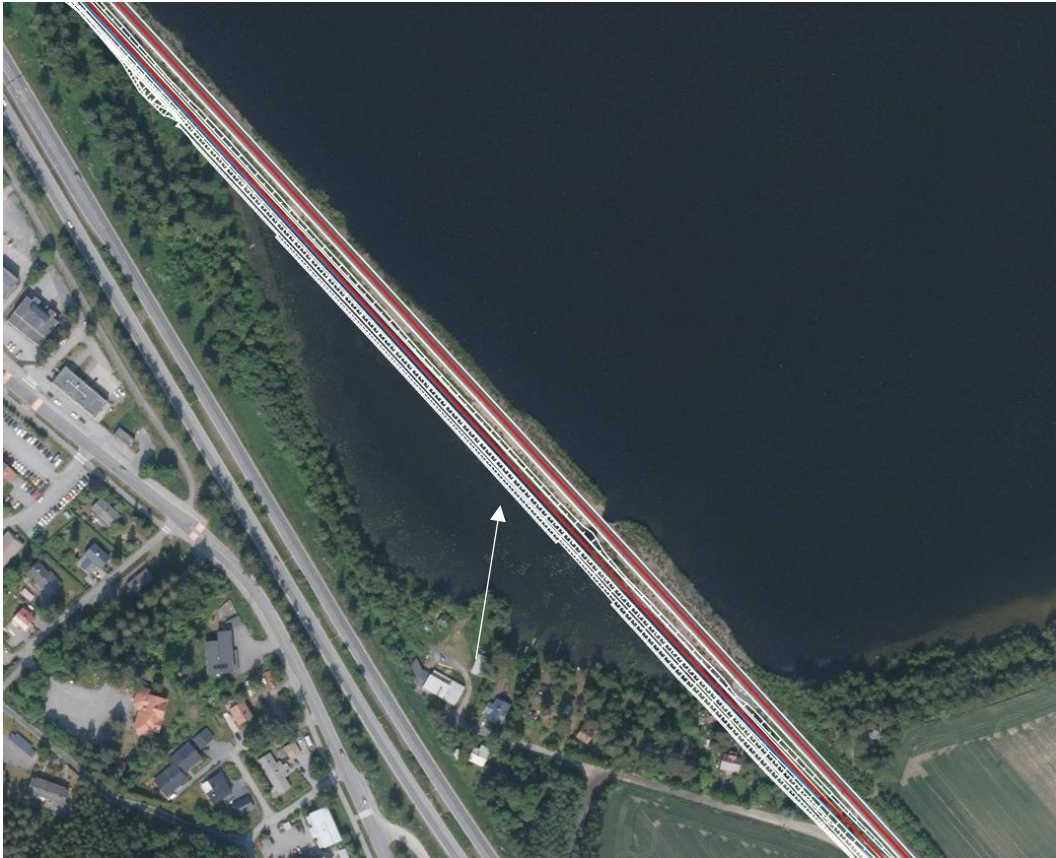
Kuva 17-5. Kaksoisraiteen vaihtoehdot 1 ja 2 ovat lähes identtiset Keijärven kohdalla. Ratapenkere levenee lounaan suuntaan. Avoimessa maisematilassa muutos näkyy voimakkaana Keijärven lounaisimpaan osaan. Maisemavaikutuksen merkittävyys riippuu tulevista suunnitteluratkaisuista.
