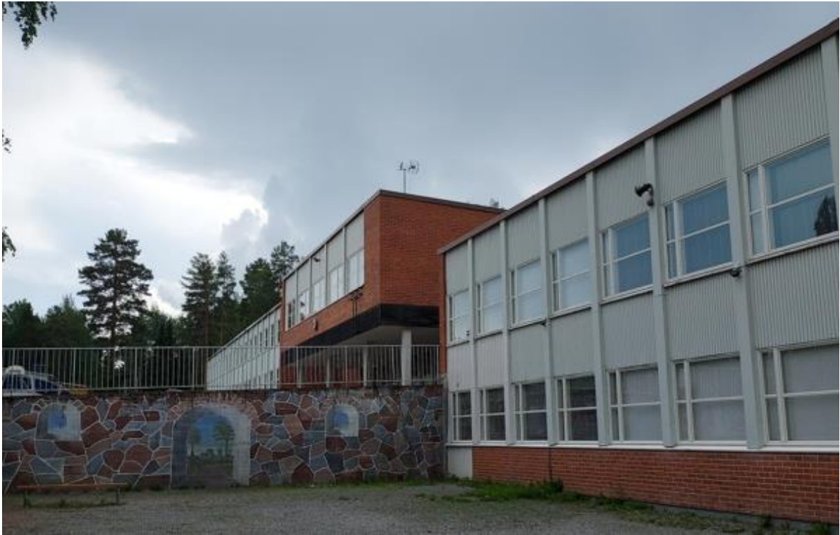
Kuva 6. Pääsisäänkäyntikatoksen pohjoisreunasta osittain purettava tukimuuri.
