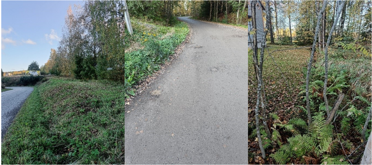
Kuva 9 Terätien alikulku. Oikealla: sisäänkäytävä (puurivin lähellä "painanne", mihin Mikkolantien alittava 800 b rumpu purkaa. Keskellä: alikulun eteläpuolella sijaitseva tien viherpainanne. Vasemmalla: Terätien pohjoispuolella ja tonttirajalla sijaitseva avo-oja.
