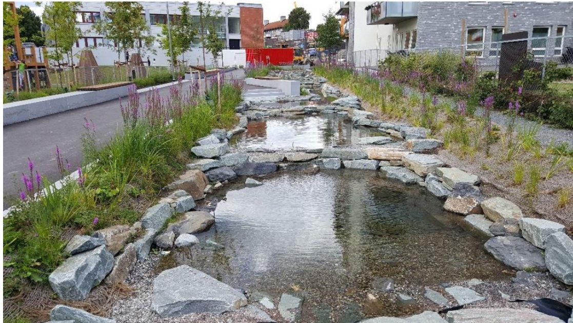
Esimerkki painanteesta, johon on tehty pohjapatoja viivytyksen aikaansaamiseksi (Vuorentaustan alueen hulevesiselvitys, Sitowise 2009)
