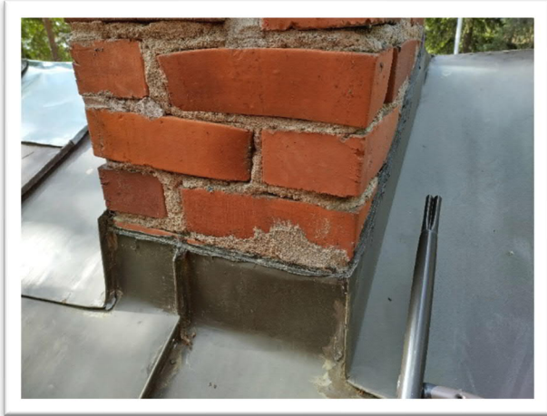
KUVA 1 ja 2: Piipunjuuri, lapetikkaat ja kattopeltien paikkaukset vaikuttavat olevan kunnossa.
