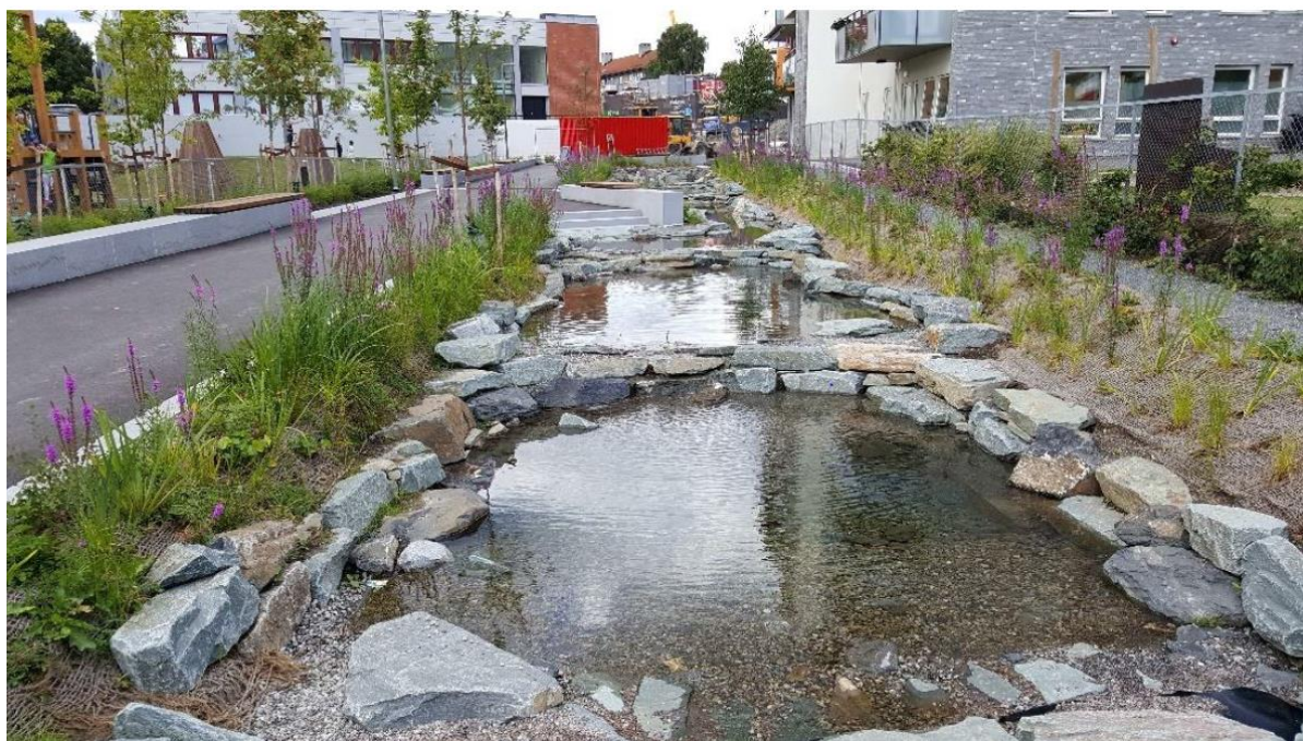
Kuva 18. Esimerkki painanteesta, johon on tehty pohjapatoja viivytyksen aikaansaamiseksi (Hatolan alueen hulevesiselvitys, Sitowise 2009)
