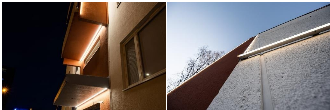
Esimerkkejä julkisivuvalaistuksesta. Kuvat: KVS Oy
