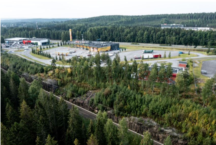
Kuva: Näkymä lounaaseen Hiitintien, Ilmarinjärvenkadun ja Vaasantien risteykseen sekä raviradalle ja Teivaalanharjuun (Rami Marjamäki 2022)
