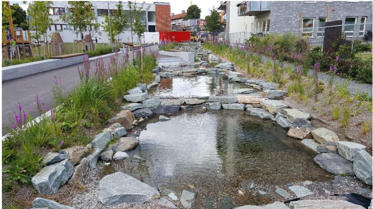
Kuva 9. Esimerkki painanteesta, johon on tehty pohjapatoja viivytyksen aikaansaamiseksi (Hatolan alueen hulevesiselvitys, Sitowise 2009)
