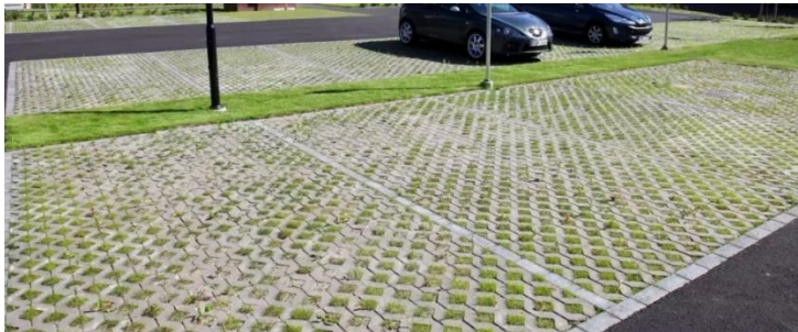
Parkkiruudut erotettu muista liikenneväylistä luonnonkiviraidalla ja nurmikivilaataalla. (kuva: Benders Oy ja Rudus Oy)
