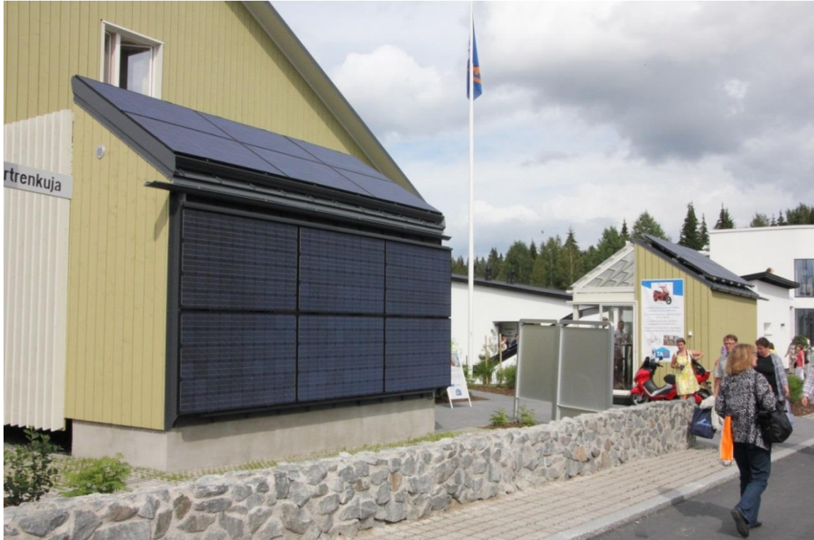
Aurinkopaneeleita on sijoitettu talusrakennusten katoille ja seinään (kuva: Arja Sippola, Vuores Tampere).
