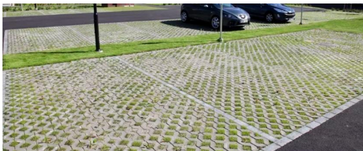
Parkkiruudut erotettu muista liikenneväylistä luonnonkiviraidalla ja nurmikivilaatalta. (kuva: Benders Oy ja Rudus Oy)
