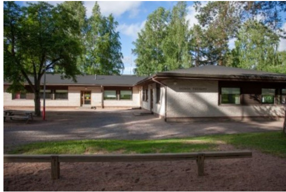
Kuvassa näkyy Saurion päiväkotikoti, jonka osoite on Seijantie 1 ja jossa nykyisellään on neljä varhaiskasvatuksen ryhmää.
